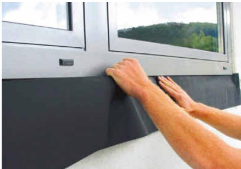
Jetzt auch vollflächig selbstklebend: Dichtfolie Iso-Connect Outside EPDM
