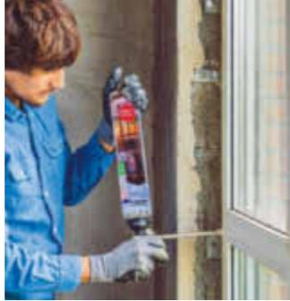
**Luftdicht ausschäumen: ClearoPag167plus machts möglich**
